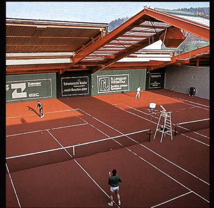
AGOB-Schiebedachhallen Tenniscenter Grütze Winterthur
