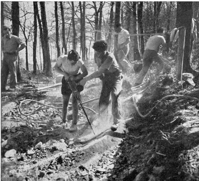
Aide-toi et le Ciel t'aidera : les I. P. vaudois construisent la route de Crêt-Bérard.
