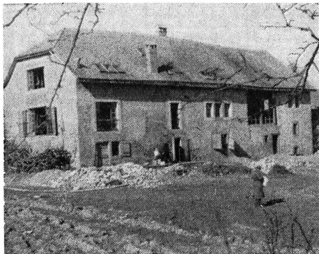
La vieille ferme qui abritera le futur Centre d'accueil et de loisirs de Chevrens s. Asnières.
