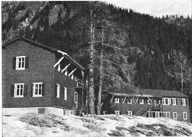
Centre sportif d'Ovronnaz (Valais)
