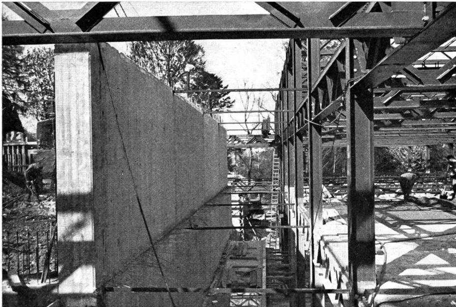
Structure d'acier avec mur d'appui comme bordure vers le nord
