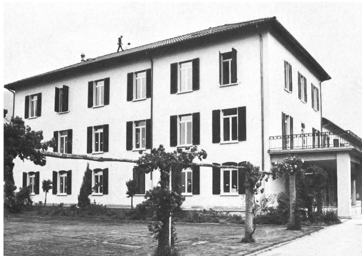
Bâtiment de logement: l'extérieur...
