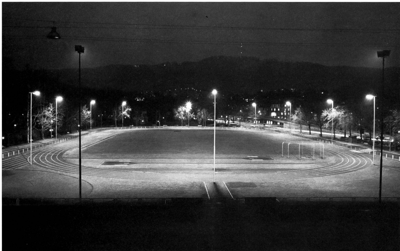
Installations d'athlétisme du Sihlhölzli, Zurich.
