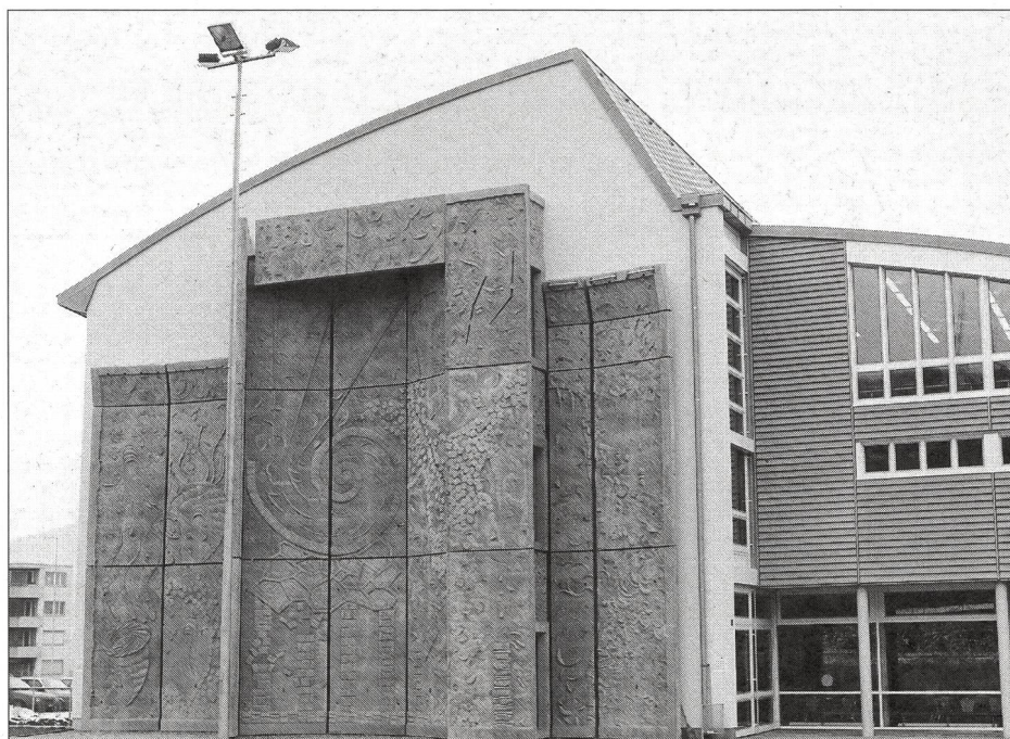
Mur d'escalade à Liestal.
