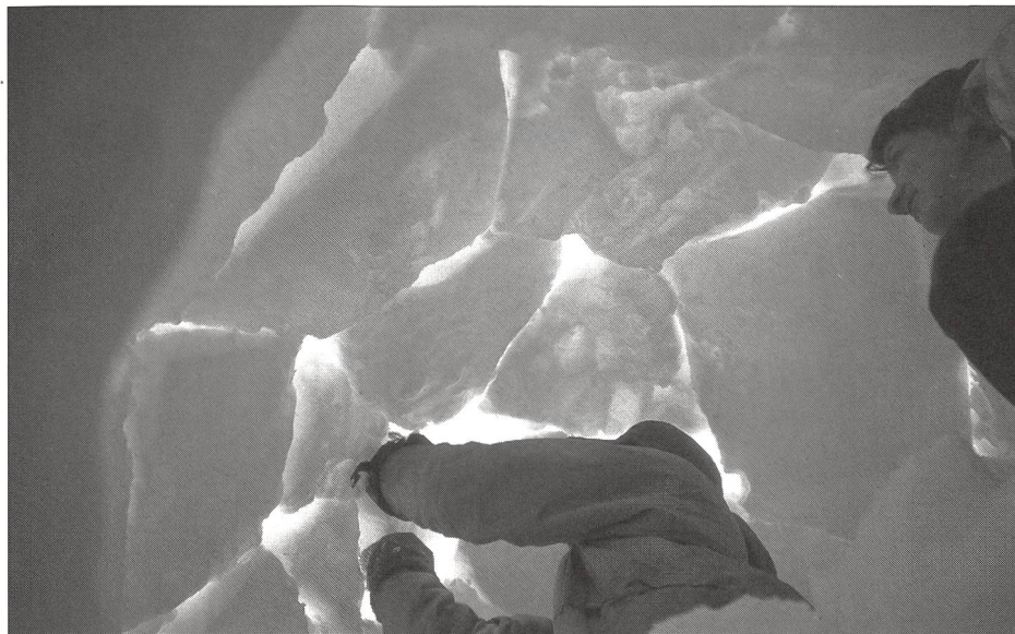
Les derniers blocs sont posés depuis l'intérieur.
