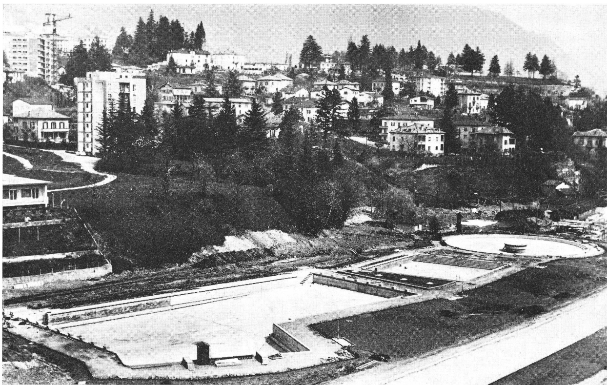
La piscina in cantiere
