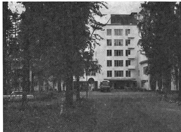
L'edificio principale della scuola di sport finlandese
