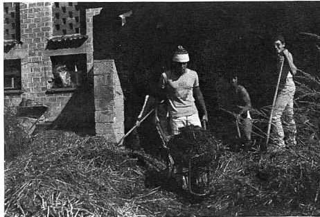
Lavori da cow-boys
