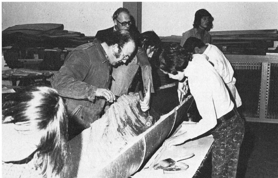
Anche i kayak da regata possono essere costruiti con il sistema «do it yourself». Eccone un esempio da un corso di disciplina sportiva G+S.
