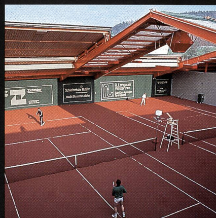
Palestra con copertura mobile Centro tennistico Grütze Winterthur
