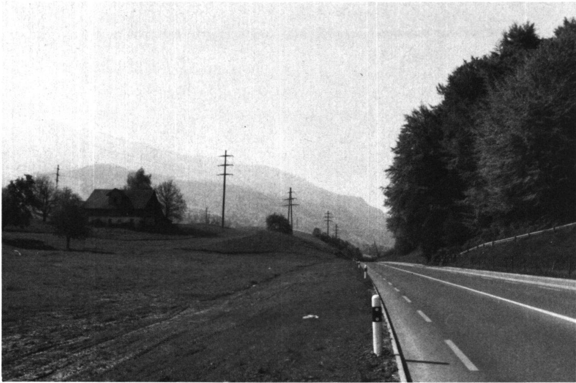
Blick auf die Wasserscheide zwischen Zuger- und Vierwaldstättersee. Kantonsstrasse Risch – Küssnacht.
