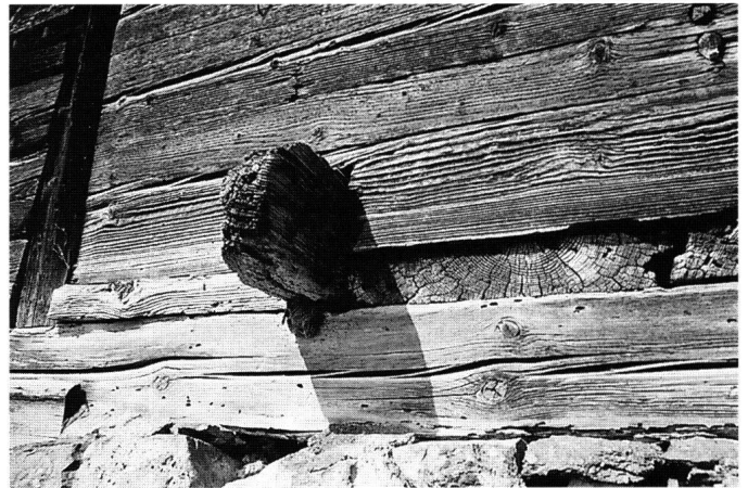
Abb. 15: Westfassade gegen Nordosten. Einzelvorstoss einer Zwischenwand und fassadenbündige Decken-Boden-Bohlen
