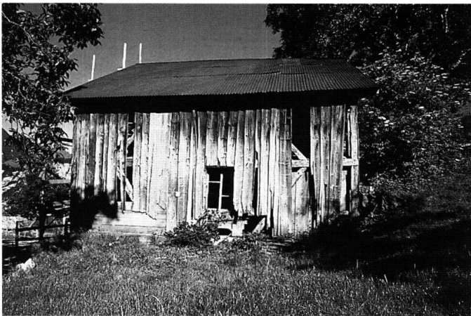
Abb. 18: Ansicht der Südfassade mit der bretterschalten Laube.
