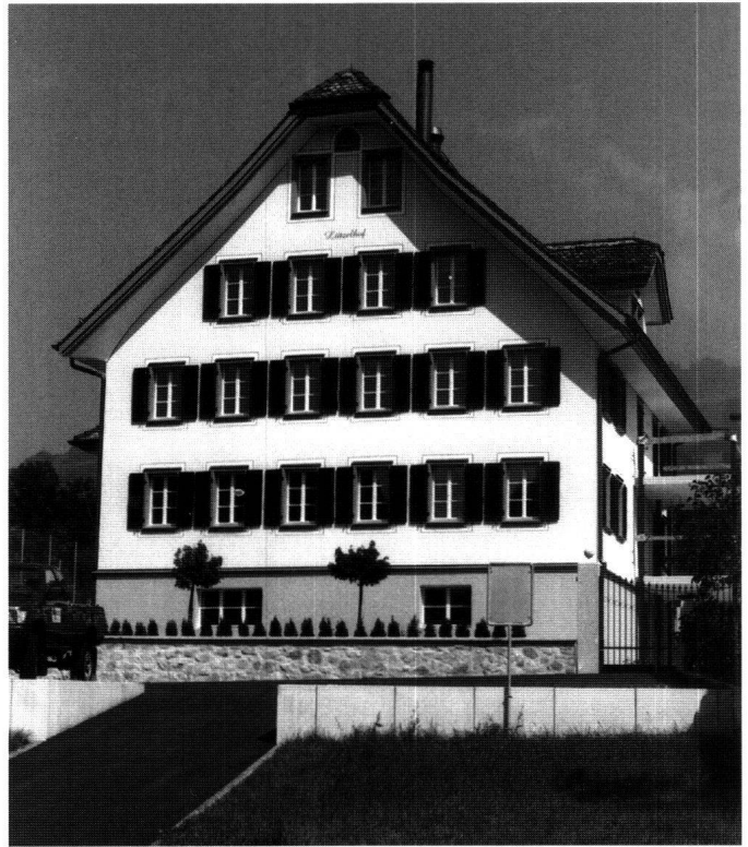
Abb. 14: Schwyz, Haus Schnüriger. Das heutige Erscheinungsbild als verputztes Holzhaus stammt aus dem späten 18. Jahrhundert. Dahinter versteckt sich jedoch Bausubstanz, die bis ins 16. Jahrhundert zurückreicht.
