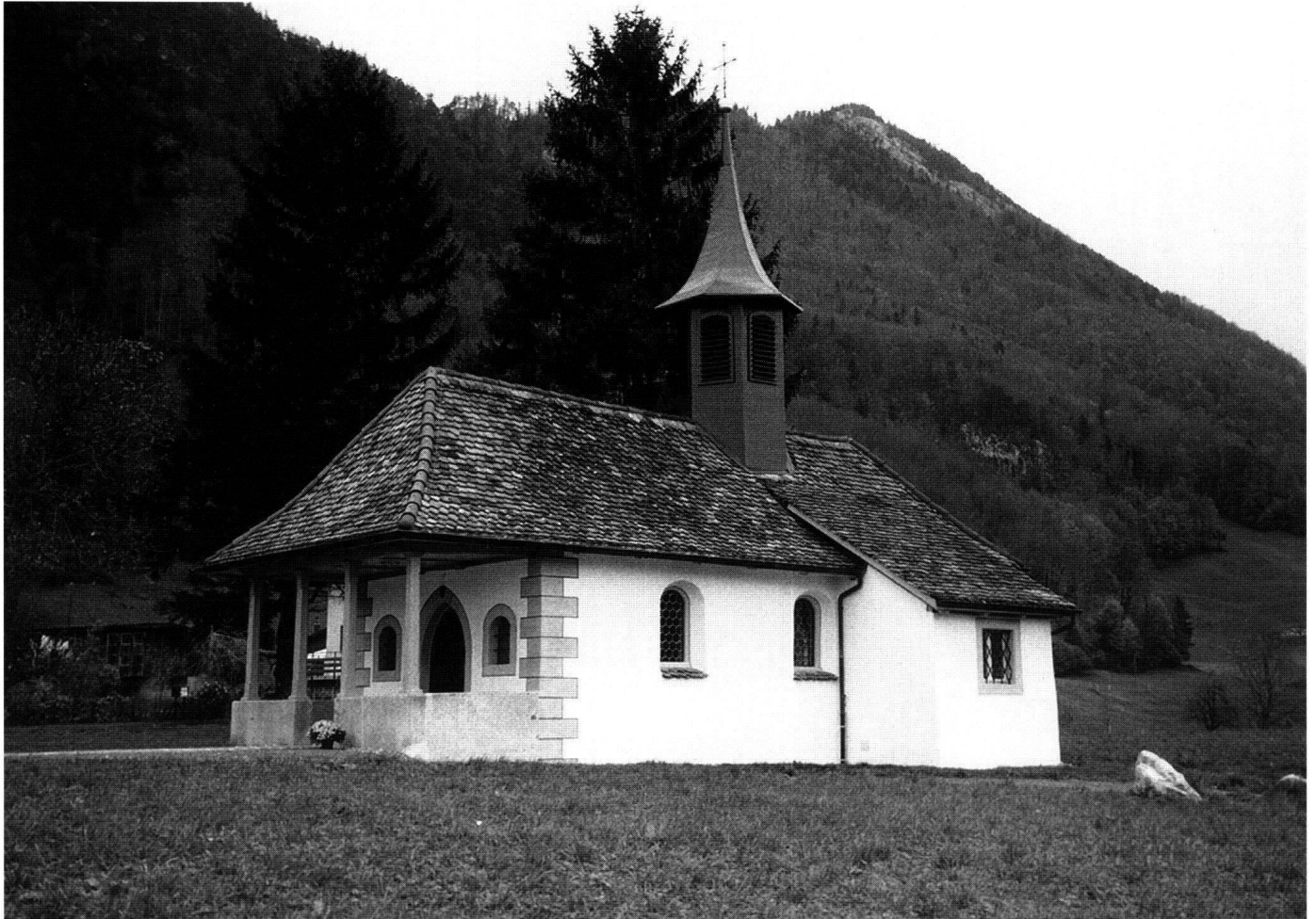
Abb. 15: Ingenbohl, Kapelle St. Laurentius, Wilen. Das Äussere nach der Restaurierung. Das Vorzeichen steht auf grossen Granitplatten, die aus Findlingen gehauen wurden. Die Ecken der Eingangsseite sind mit grossen aufgemalten Quadern dekoriert.
