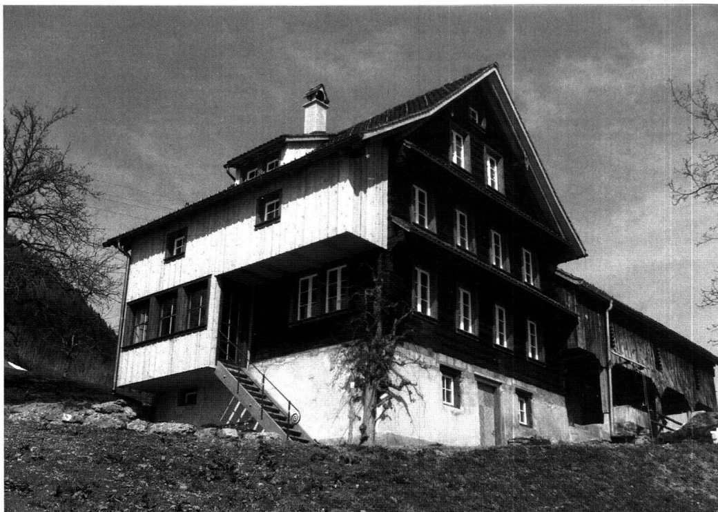
Abb. 20: Sattel, Haus Magrainweg 17. Das Bauernhaus gehört zum seltenen Typ des Gadenhauses, bei dem Wohnhaus und Stall zusammengebaut sind. Dabei steht der First des Stalles quer zu demjenigen des Hauses.
