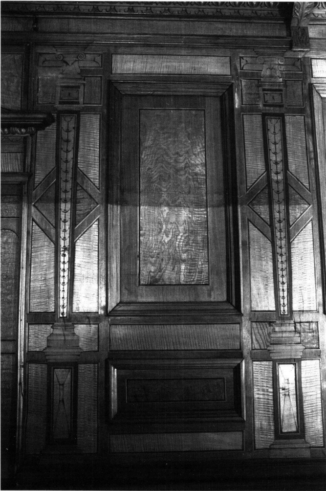
Abb. 3: Schwyz, Ital Reding-Haus, Kleiner Saal. Ausschnitt aus dem Wandtäfer mit Probefreilegung. Oben ist der stark nachgedunkelte Firnisüberzug sichtbar. Unten ist dieser entfernt und der ursprüngliche Leimüberzug aufpoliert.
