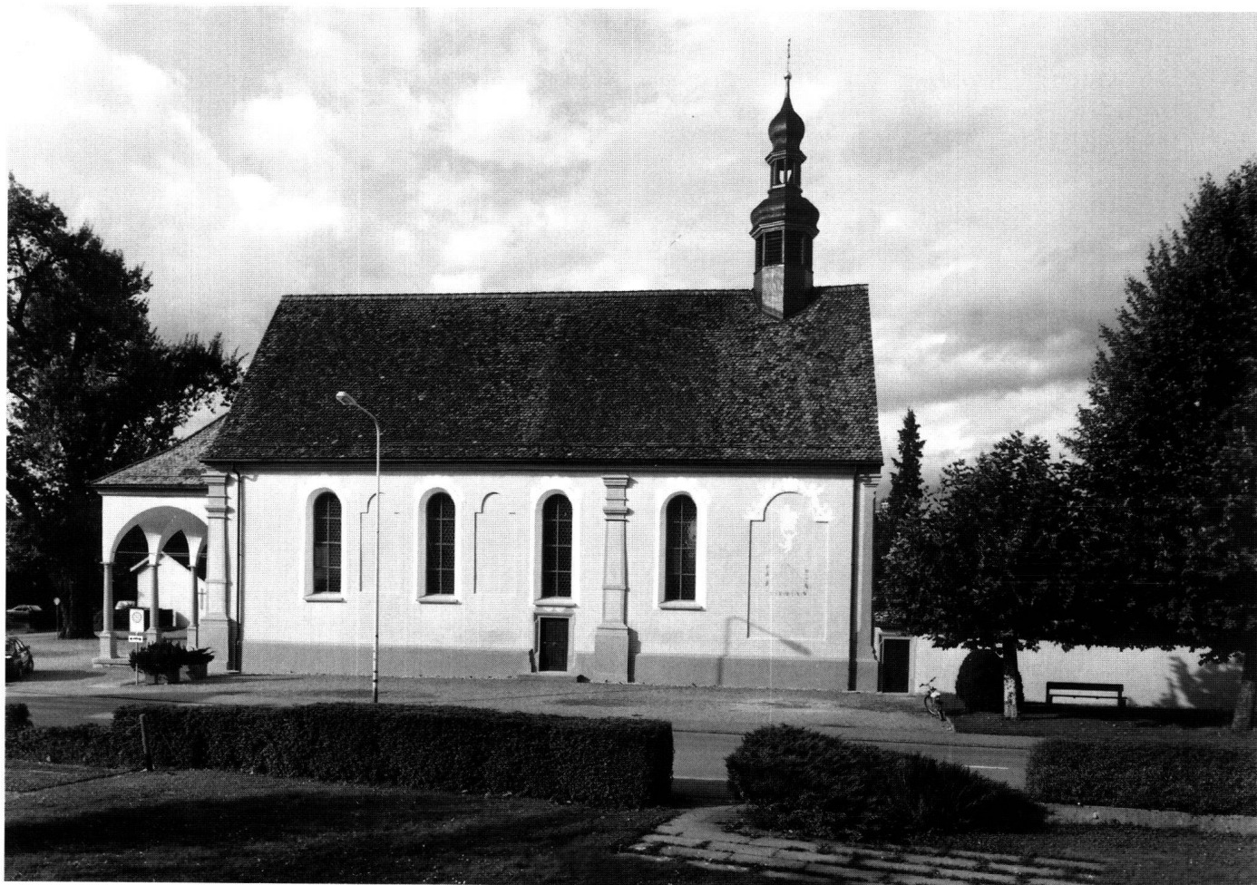
Abb. 21: Lachen, Riedkapelle. Die ursprünglichen Fenster von 1680 sind als Blendnischen ablesbar. Die Sgraffiti entstanden im Zusammenhang mit den neuen Fenstern in der ersten Hälfte des 18. Jahrhunderts. Aus der gleichen Zeit stammt das Vorzeichen.
