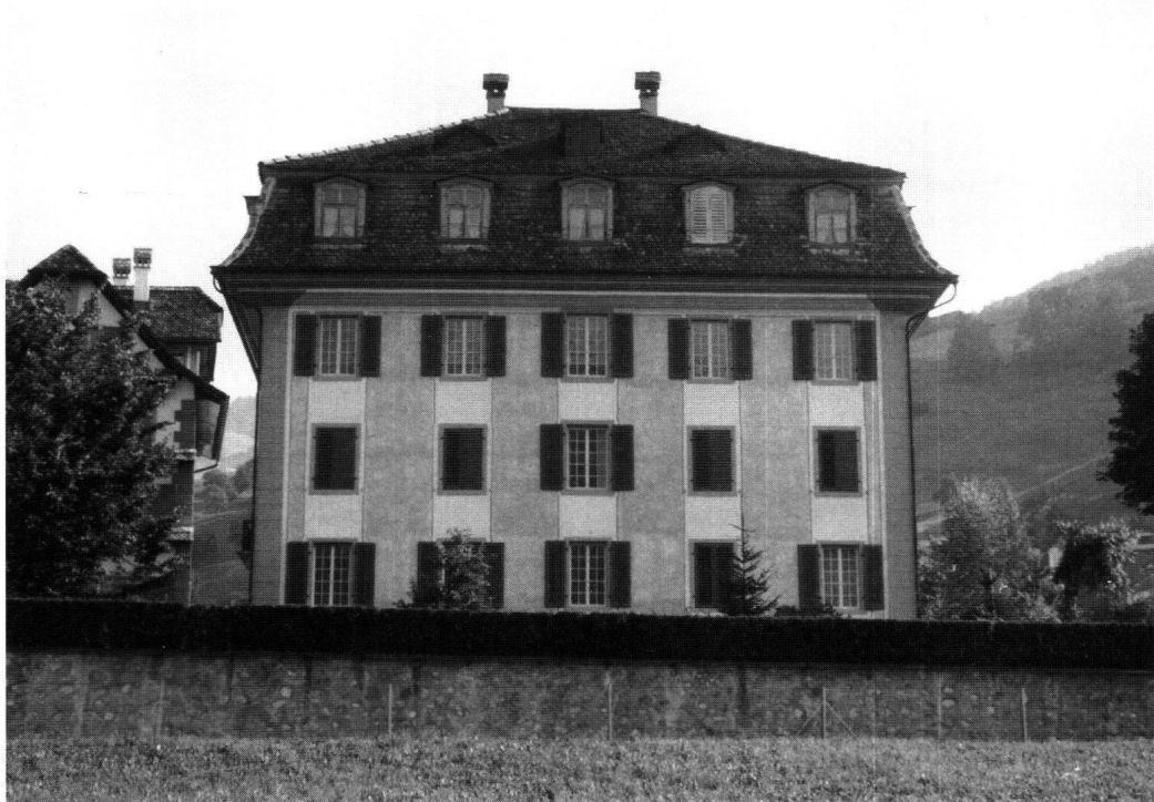
Abb. 4: Schwyz, Haus von Hettlingen. Die Südfassade nach der Wiederherstellung der differenzierten Fassadengliederung mit Rauputzfeldern und hell bemalten abgeglätteten Flächen.
