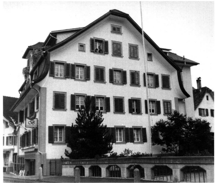
Abb. 12: Steinen, Haus Schwyzerstrasse 1. Barocke Formen wie das Mansarddach wurden noch bis Ende des ersten Drittels des 19. Jahrhunderts angewandt.
