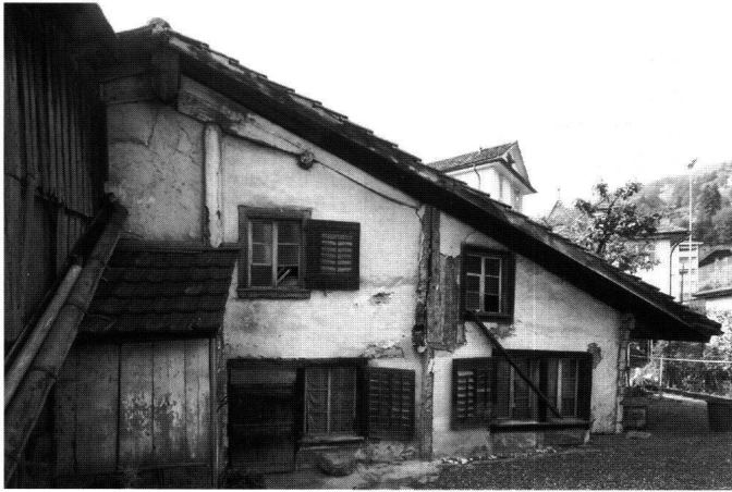
Abb. 43: Südfassade, östlicher Teil: Zustand bei Beginn der Untersuchungen 1998.
