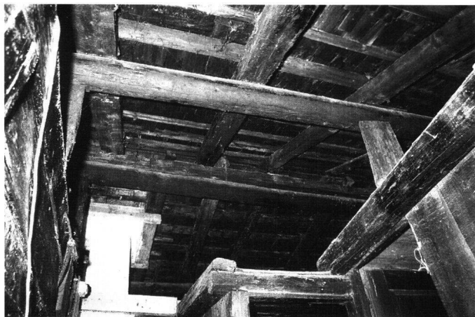
Abb. 21: Dachunterseite mit sekundären Kammereinbauten, Ansicht gegen Südosten.
