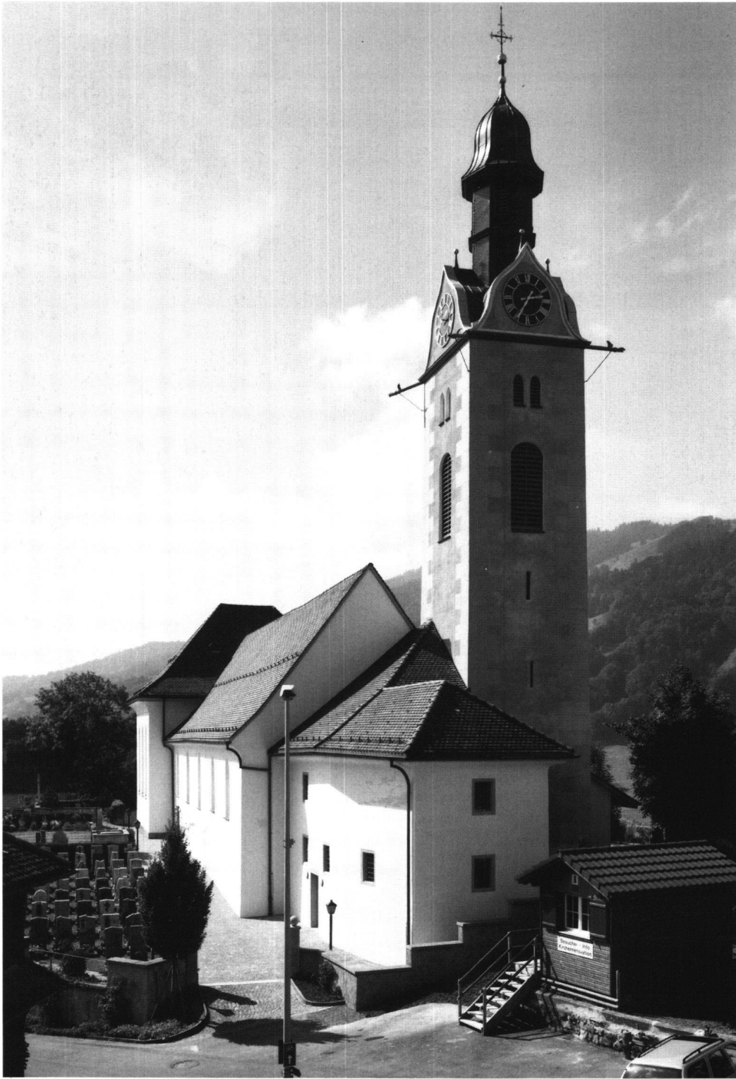
Abb. 10: Sattel, Pfarrkirche St. Peter und Paul. Die nach Befund wiederhergestellten Fassaden und Turm.
