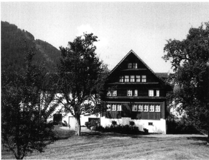
Abb. 17: Schübelbach, Haus Ziegelhof. Unter der Vertäferung des ersten Wohngeschosses verbirgt sich ein ca. 250 Jahre älterer Kern. Vermutlich wurde das Haus 1807 aufgestockt und erweitert.
