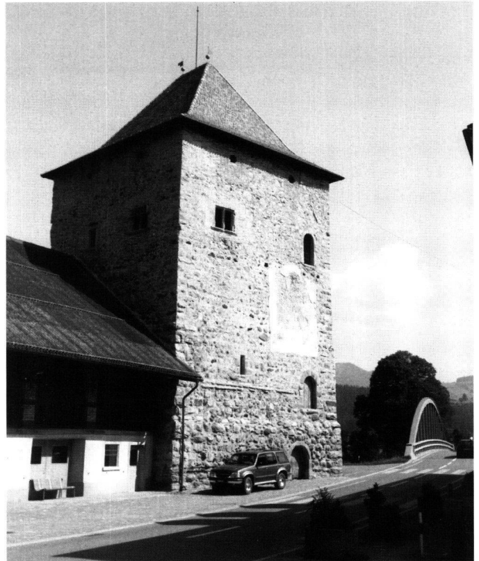
Abb. 20: Tuggen, Schlossturm Grinau. Der Turm nach der Restaurierung.
