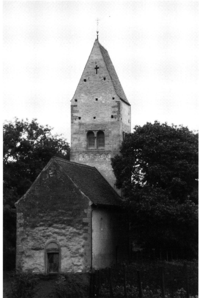
Abb. 25: Freienbach, Kirche St. Peter und Paul, Ufnau. Kirchturm nach der Putz- und Steinkonservierung.
