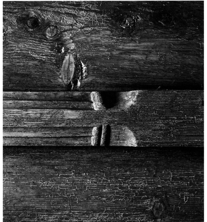
Abb. 11: Erstes Wohngeschoss, Kammer 1.6, profilierter Balken der Bohlen-Balkendecke.
