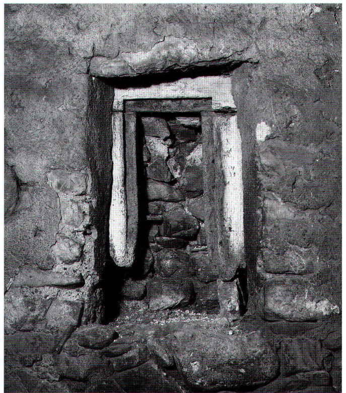
Abb. 27: Erdgeschoss/Kellerraum 0.2, Binnenwand. Fensteröffnung mit hölzernen Rahmen.
