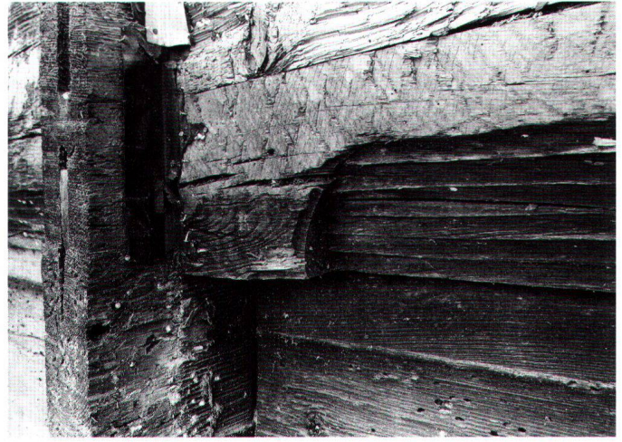
Abb. 19: Südfassade, Detail des eichenen Rillenfrieses des ersten Obergeschosses.
