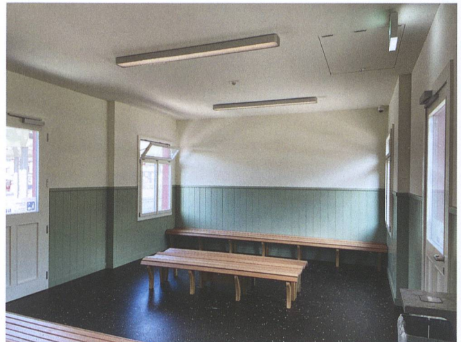
Abb. 7: Arth, Goldau, «Chalet»-Kiosk: Innenansicht des neuen Warteraumes.
