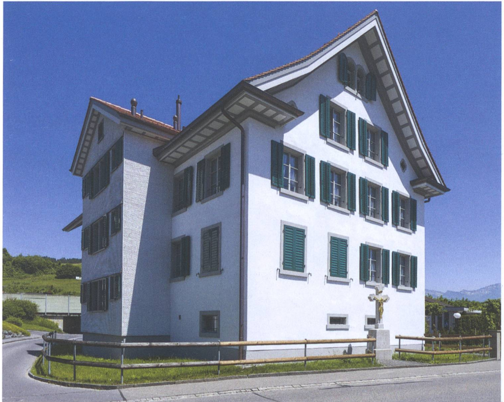
Abb. 10: Wangen, Pfarrhaus: Aussenansicht von Südwesten.
