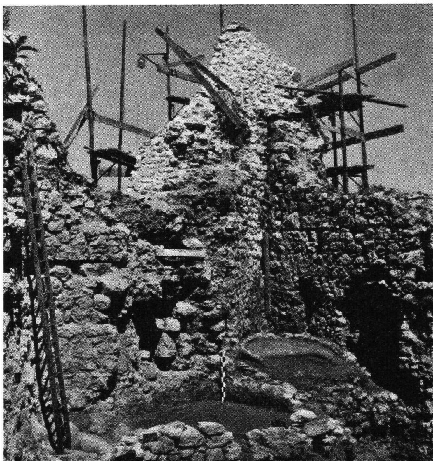
Burginneres (M), Blick gegen NE, nach der Grabung, mit Baugerüst.
