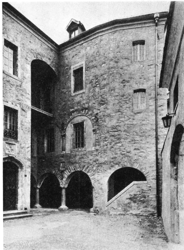
Monthey VS. Schloß, Hofansicht nach der Restaurierung
