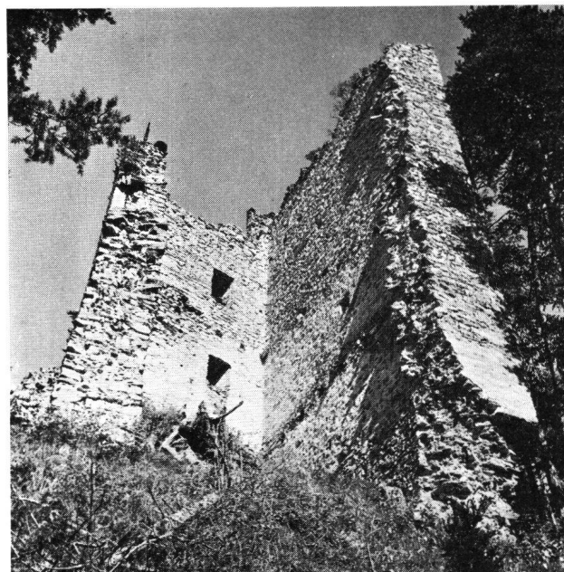
Ober-Ruchenberg GR Turm-Ansicht von SW
