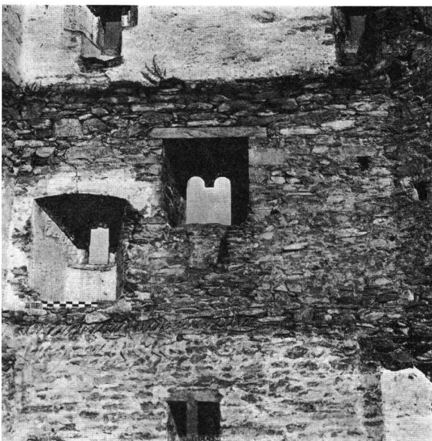
Haldenstein GR Palas E-Innenwand mittl. Drittel
