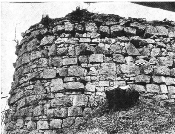
Wartburg, Wohnturm von Norden.
