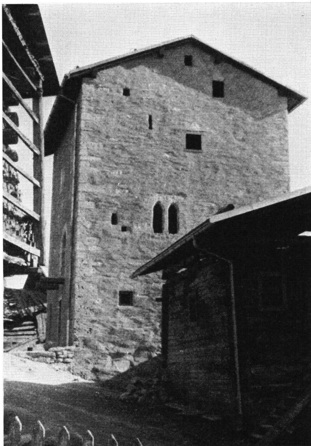
Turm Cas'aulta. Ansicht von Westen nach der Restaurierung
