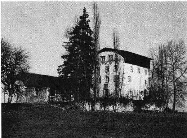
Ansicht von Südosten, Herrenhaus mit Notdach, links Ökonomiegebäude, im Vordergrund die Fundamente der Rundtürme und Wehrmauern.
