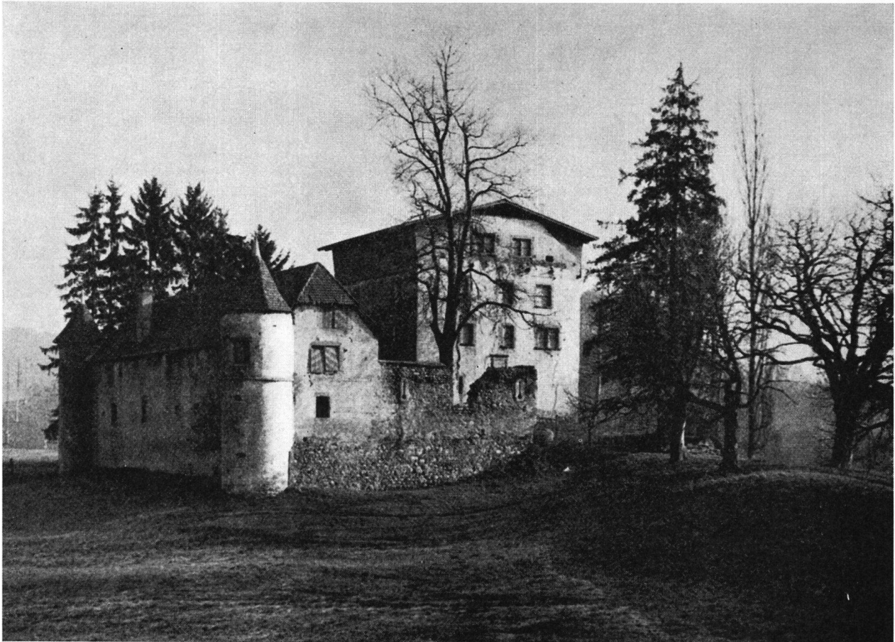
Schloss Wyher bei Ettiswil, Kanton Luzern. Ansicht von Südwesten, links Ökonomiegebäude mit zwei runden Ecktürmen, teilweise abgebrochene Wehrmauer mit Einfahrt, dahinter das Herrenhaus mit Notdach. Vorgelände ehemals Weiher.
