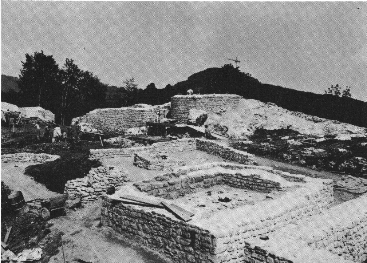
Frohburg. Mauerwerk unmittelbar vor Abschluss der Restaurierung. Blick gegen die mittlere Zisterne und das Rundhaus
