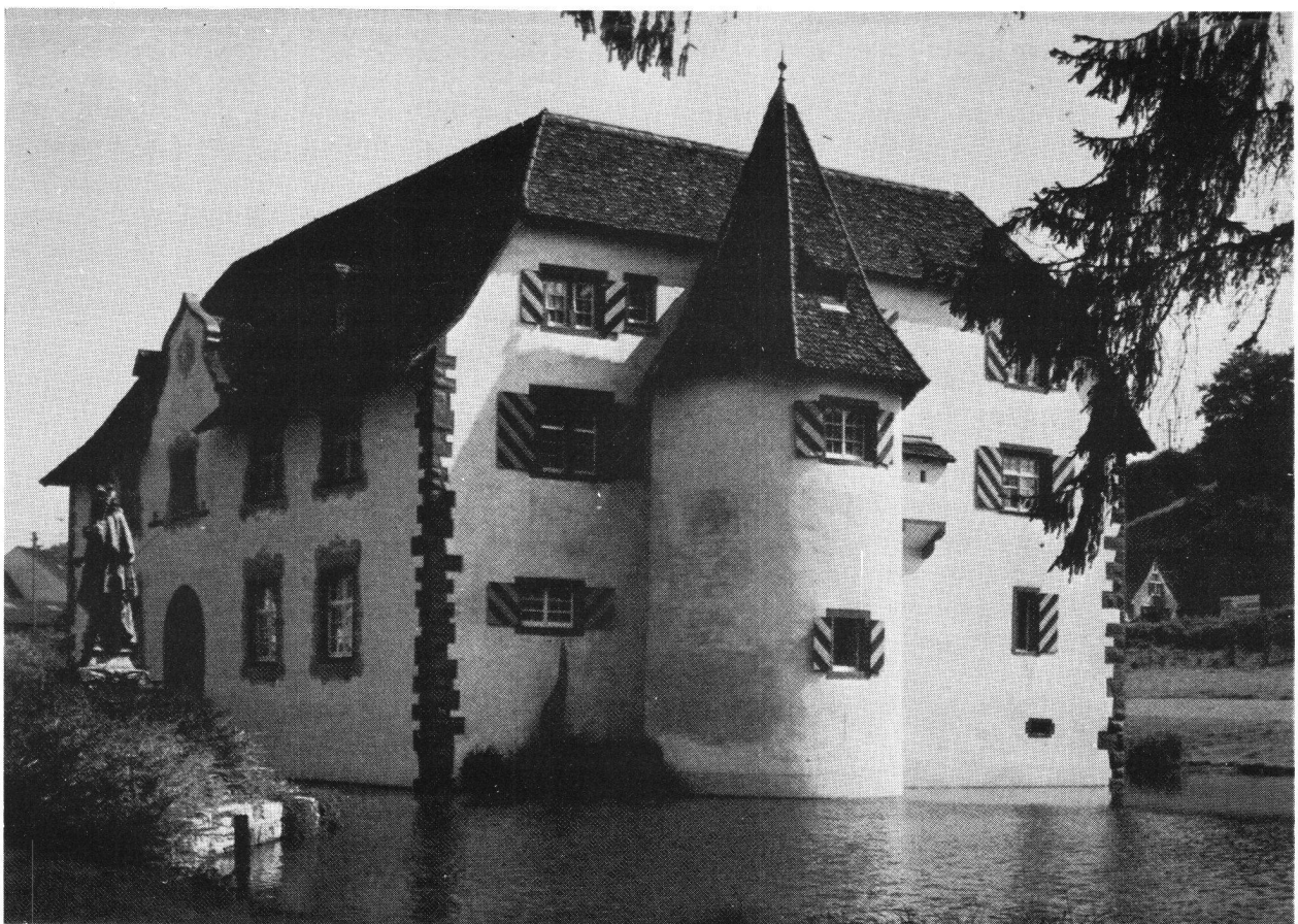
Wasserschloss Inzlingen, nach der Restaurierung.
