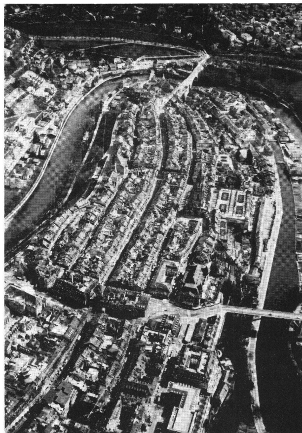
fig. 8 Bern. Photo aérienne Stuart Morgan
