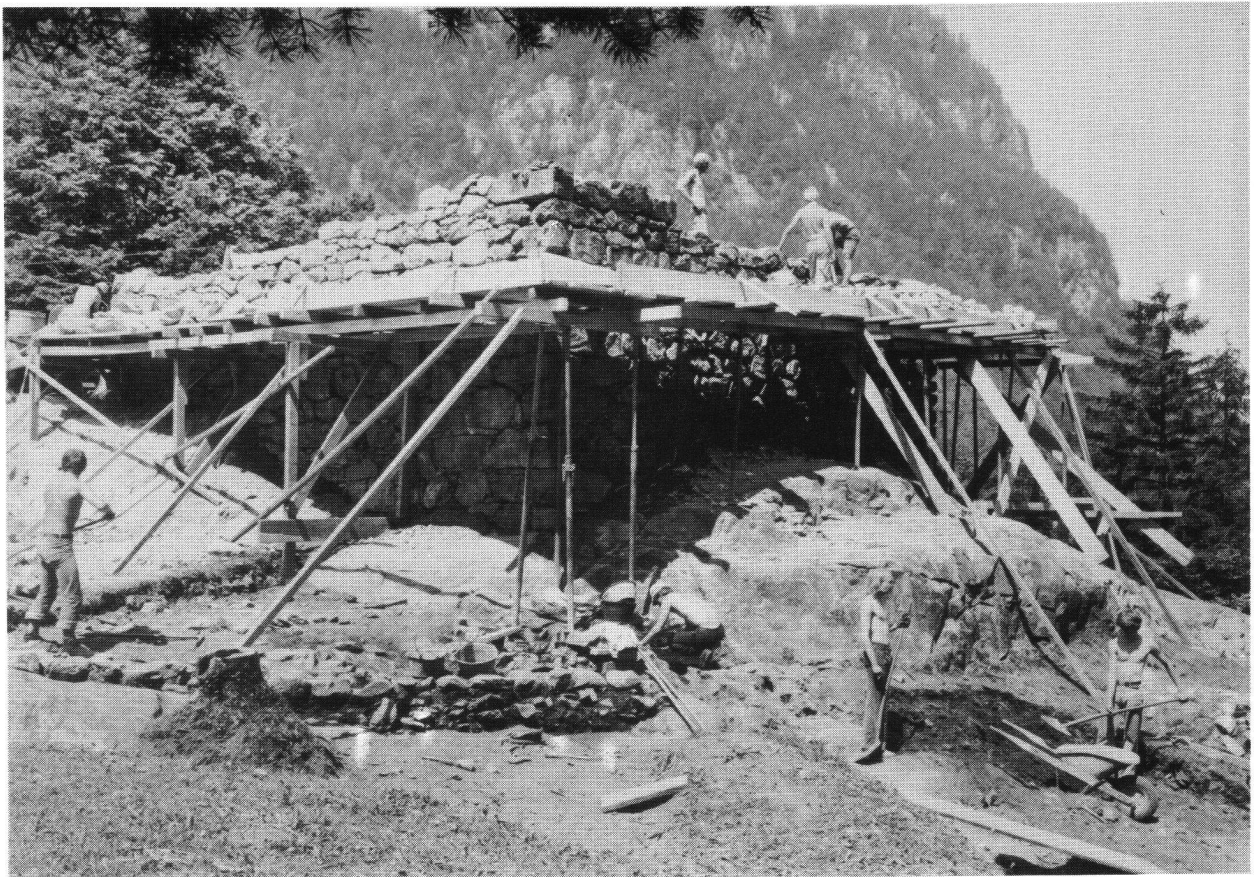
Zwing Uri UR. Turm während der Konservierung. Im Vordergrund Freilegung des Mauerfundamentes aus dem frühen 14. Jahrhundert. Blick gegen NW.
