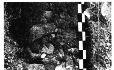
Riedflue, Quermauer M 5, Ansicht westliches Mauerhaupt mit Rasa pietra-Verputz
