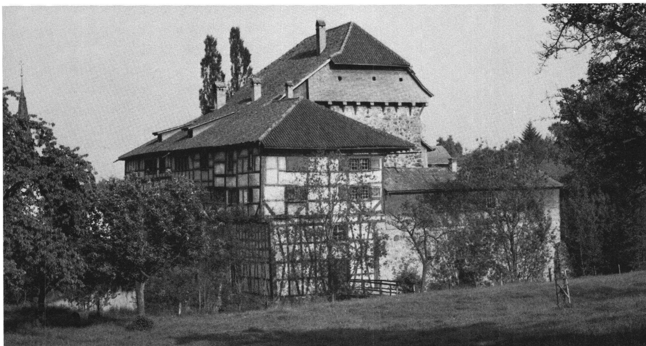
Hagenwil TG. Als ältester Teil der Wasserburg erhebt sich im Zentrum der mächtige Turm mit Walmdach.
