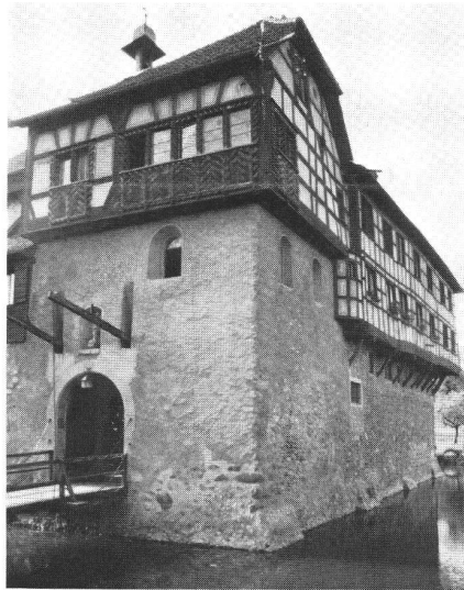
Hagenwil TG. Haupttor mit Zugbrücke.
