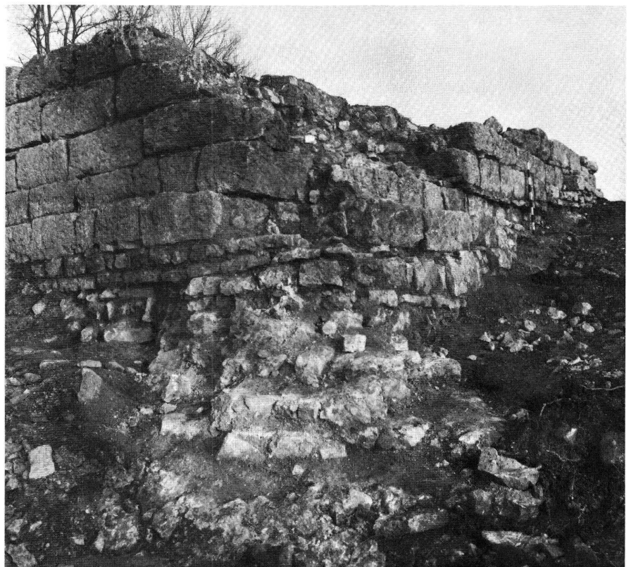
Ostturm von Süden mit der von der Ecke abzweigenden Zwingermastmauer.
