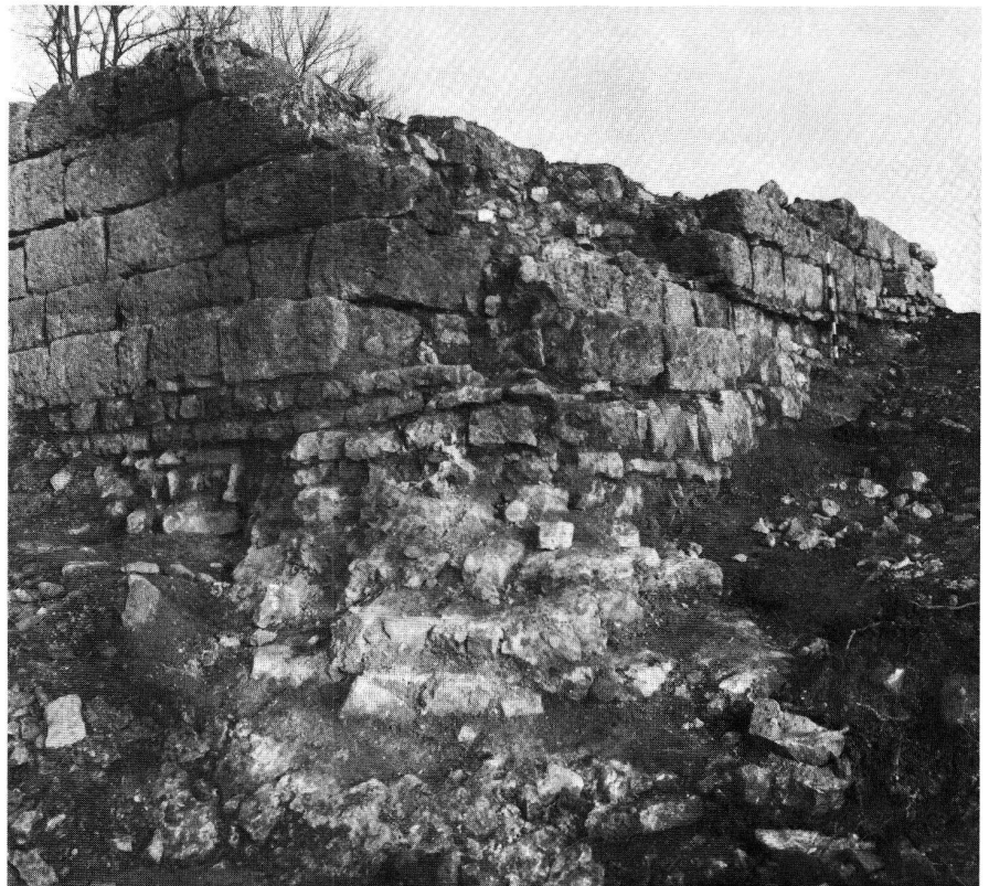
Ostturm von Süden mit der von der Ecke abzweigenden Zwingerostmauer.
