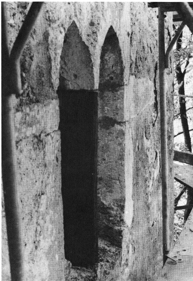
Neu-Thierstein, spitzbogiges Doppelfenster in der N-Wand des Wobenturms. Zustand von 1984.
