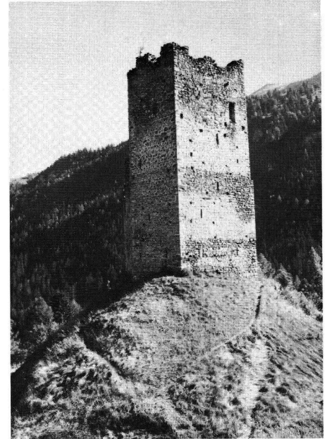
Strassberg GR. Hauptburg mit Turm von SW.
