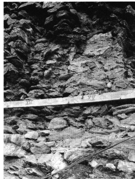
Verputz mit Fugenstrich beim Ausbruch des Hauptturmes von Westen. (Foto: ADG)
