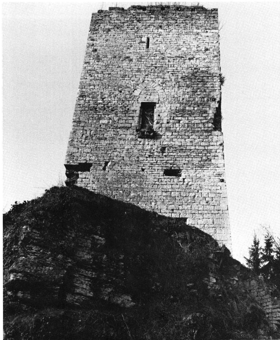
Photo 4 Tour de Milandre, façade nord-est, avant la restauration. Vue prise depuis le niveau inférieur du château fort. Cette photographie servait avec d'autres comme base de l'analyse photogrammétrique du donjon. (Photographie Leupin)
