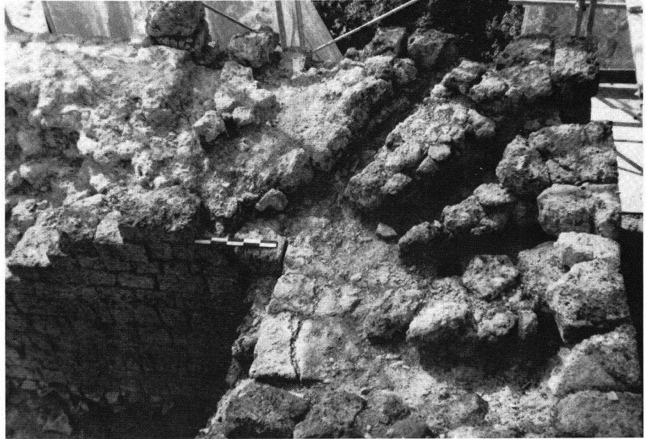
Photo 12 Tour de Milandre, sommet dégagé et nettoyé. Système de chenaux de poutres saillantes en encorbellement sur les murs. Cette installation a seulement été trouvée sur le côté vallée.
