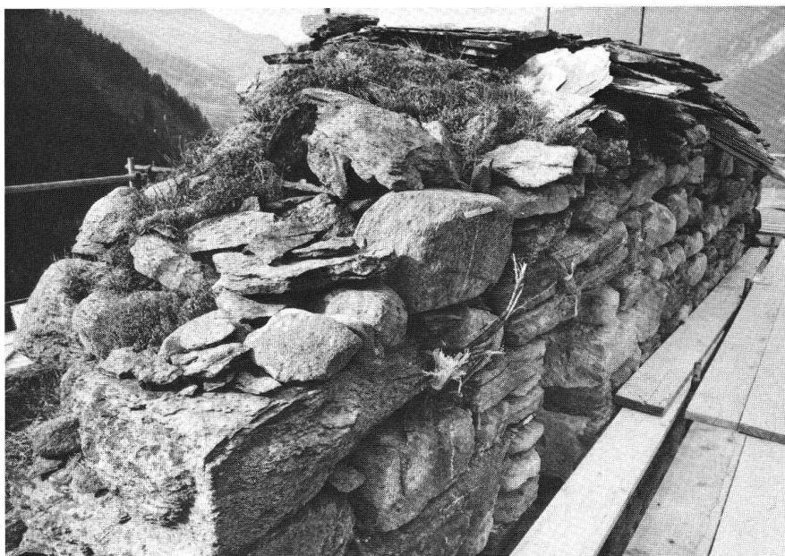
Cagliatscha, Dachpartie, Vorzustand.
