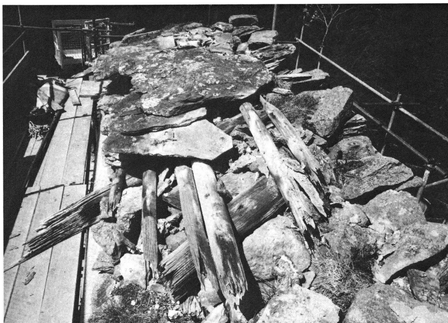
Cagliatscha, Dachpartie teilweise abgedeckt.
