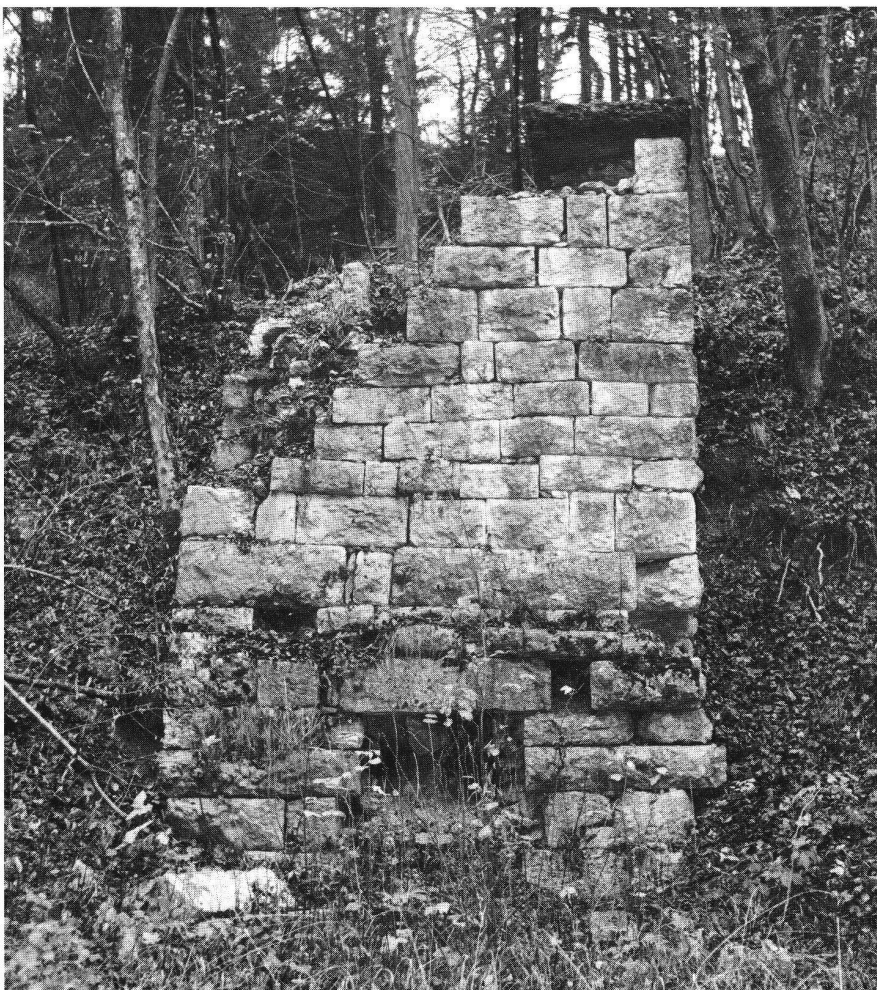
Abb. 3: Schachtkalkofen von Rickenbach SO. Der Ofenmantel besteht aus sorgfältig gefügten Kalksteinquadern; das Ofeninnere ist mit Schamotsteinen ausgefüllt.
