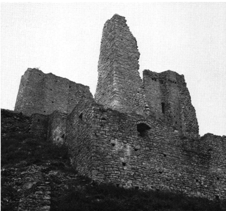
Schenkenberg, Ruinen der zentralen Wobngebäude
