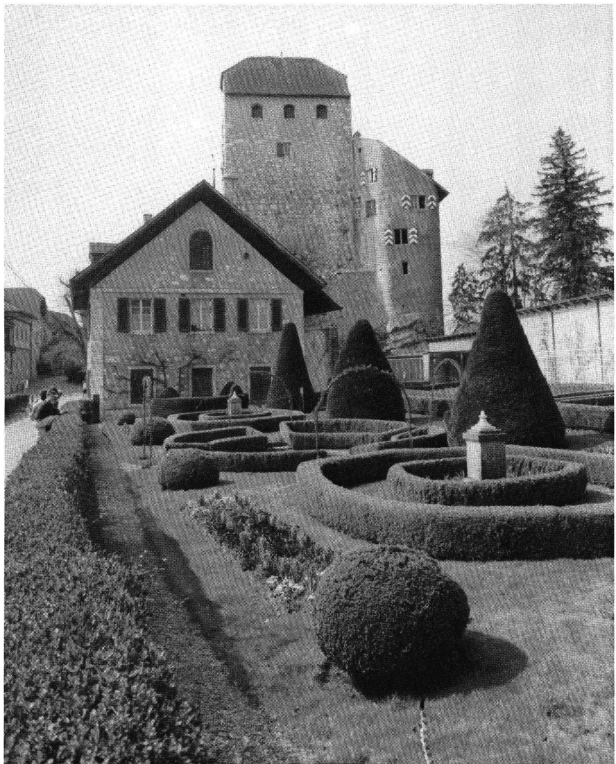
Möriken AG. Wildegg, Burgturm mit jüngeren Anbauten und Nebengebäuden
