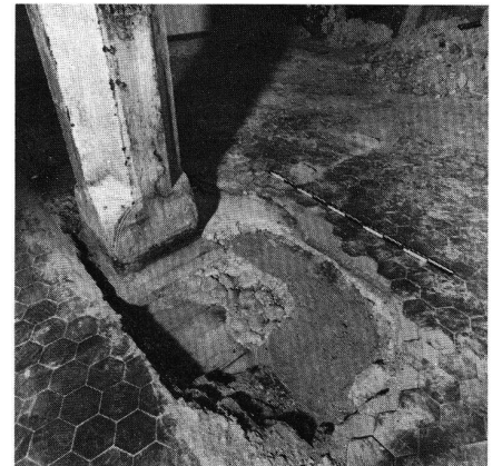
10 Unter dem modernen Küchenboden hat sich der originale Bodenaufbau, Bodenbretter und Rollierung mit Mörtelguss erhalten.
