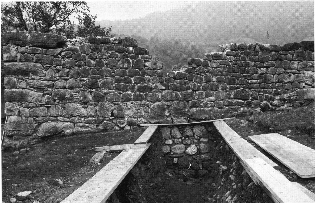
Abb. 1: Turmruine im Kleinteil, Mauer M 1 von Osten mit dem an die Mauer anschliessenden Schnitt S 1. (Foto Theo Frey)
