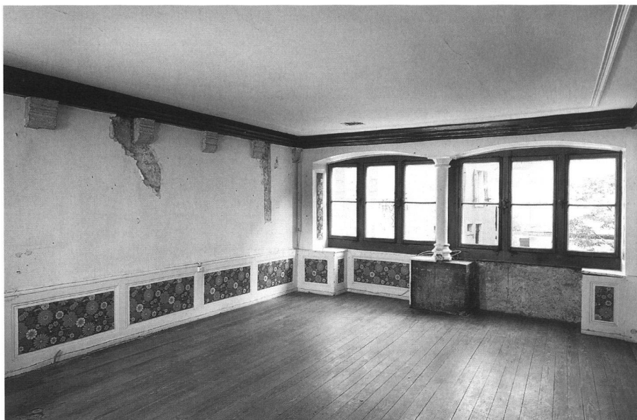
13: Yverdon – Rue du Collège 10. Vue de la grande chambre sur rue du premier étage avec ses deux triplets de fenêtres à coussiège.
