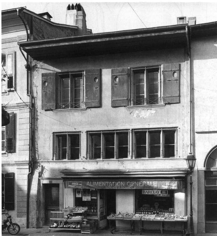
8: Yverdon – Rue du Collège 10. La façade sur rue.
