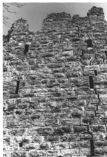
1: Alberswil LU, Kastelen. Westseite. Quadermauerwerk aus leicht bearbeitbarem Tuffstein.
