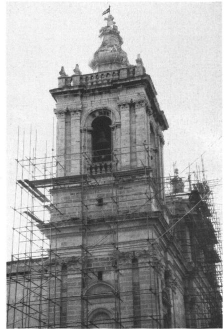
18: Vittoriosa (Birgu), Malta. Mit Stahlbrenn eingüsteter Kirchturm. Wie im Mittelalter üblich, sind nur die zur Ausführung der laufenden Arbeiten benötigten Gerüstläufe mit Brettern belegt.
