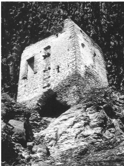
13: Marmorera GR, Ruine Marmels. Gut sichtbare Anschlusssteine in der Südmauer der ehemaligen Burgkapelle.
