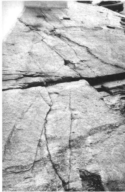
16: Flond GR, Kirche. In den anstehenden Fels gebauene Löcher zur sicheren Verankerung der senkrechten Stangen des Aussengerüsts.
