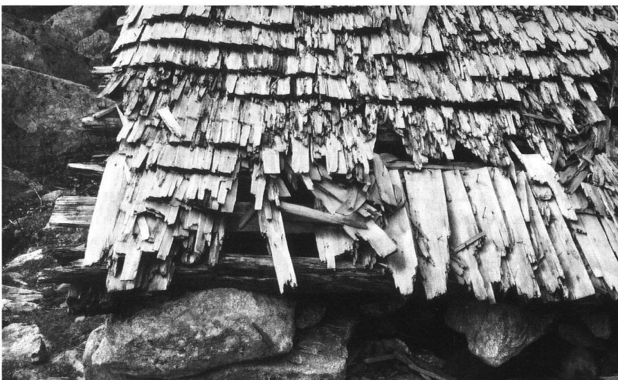
22: Meien UR. Genageltes Schindeldach einer Alpbütte am Sustenpass.
