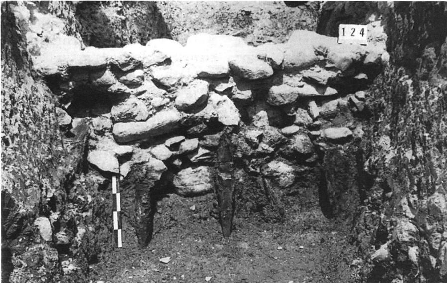
9: Sursee LU, Vierberrenplatz. Ein mit Holzpfählen gegen Abrutsch gesichertes Mauerfundament.
