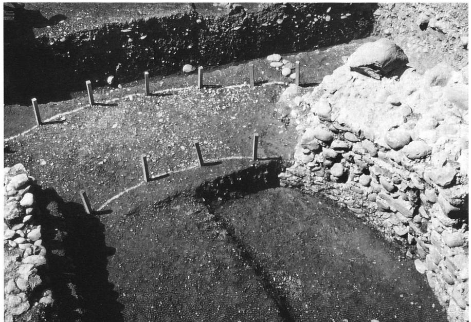
11: Bümpliz BE, Altes Schloss. Mit Latten markierte Pfostenlöcher der Pfähle, mit denen der Grundriss des Rundturmes vor dem Baubeginn abgesteckt worden ist.
