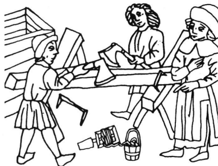
6: Zimmerleute beim Schlichten eines aufgebockten Stammes. Dies ermöglichte ein präzises Einhalten der Schnur und das Schwärzfässlein hinweist, als wolle der Baumeister auf die Schnur und das Schwärzfässlein hinweist, als wolle die Gesellen zur Exaktheit mahnen 7 .
