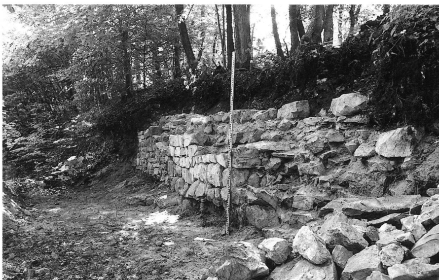
2: Zur Konservierung vorbereiteter Abschnitt der Ringmauer.
